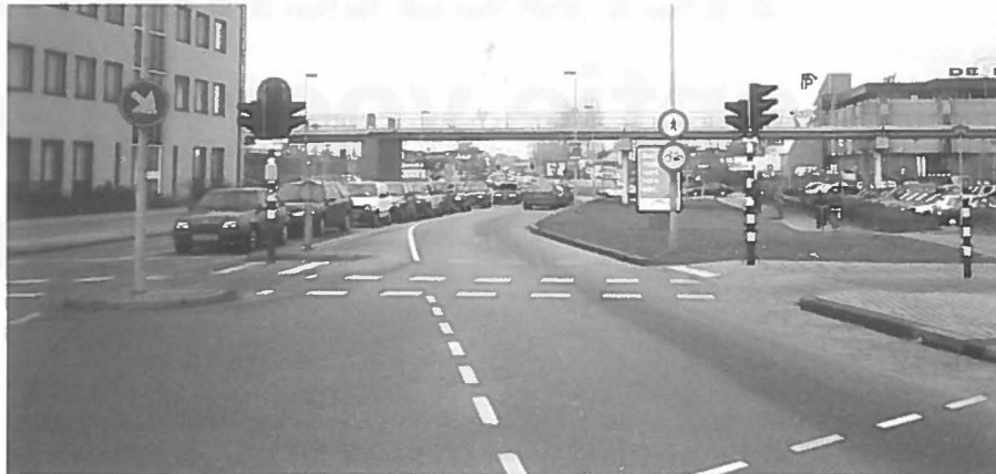
De loopbrug tussen station en winkelcentrum.
