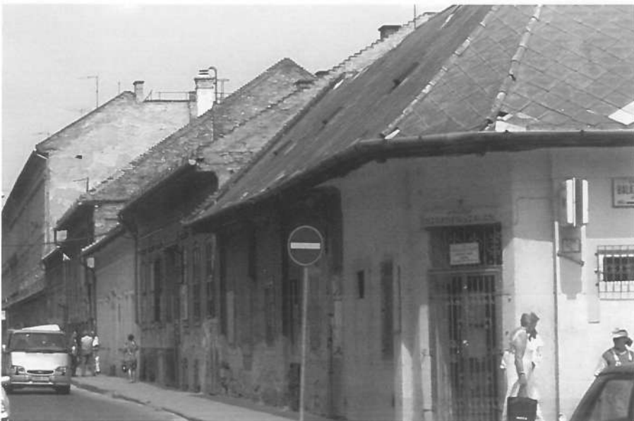
Oude laagbouw die aan renovatie toe is in de wijk Kőzépső-Ferencváros in Boedapest.
