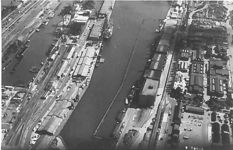
Het voormalige douane-entrepot in Amsterdam. Ook in het water is een muur gebouwd om het in- en uitgaande scheepvaartverkeer te controleren. Foto: Gemeente Amsterdam, DRO
