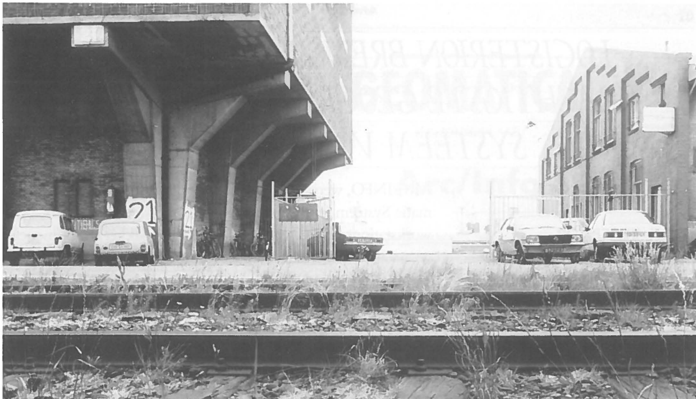
Oefenruimtes bevinden zich vaak in enigszins afgelegen gebieden, zoals hier aan de Oostelijke Handelskade in Amsterdam. In deze bedrijfsruimte is werkelijk sprake van multifunctioneel gebruik; in de kelders wordt geïnfocend, daarboven wordt soja opgeslagen. Foto: Peter Cuypers
