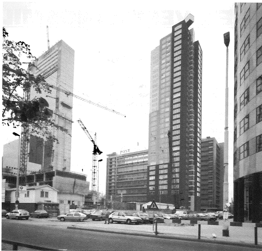
Stedelijke vernieuwing in Rotterdam: woontoren aan het Weena. Bron: BPF.
