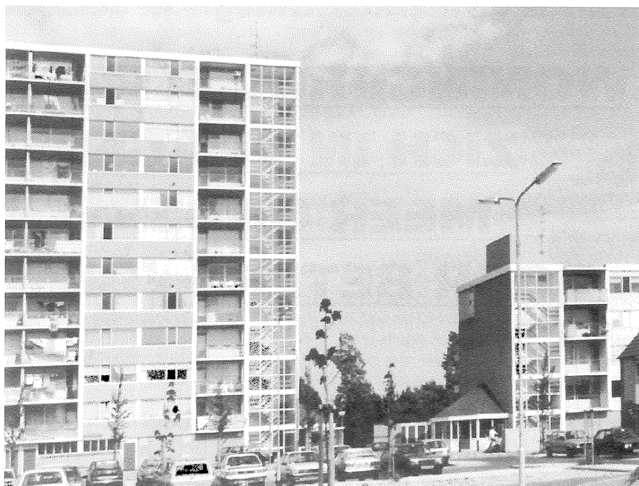
"(...) woningen in na-oorlogse wijken kunnen markttechnisch vaak niet meer mee (...)" . Rechts: Afgetopte flats in Middelburg. Foto: Martijn Gallenkamp
