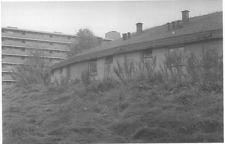
Grasdakwoningen in de Roomolenpolder in Haarlem. De grasdaken hebben een isolerende werking. In de zomer trekt het dak meer dan 15 soorten vlinders aan. Foto: David Tesselaar
