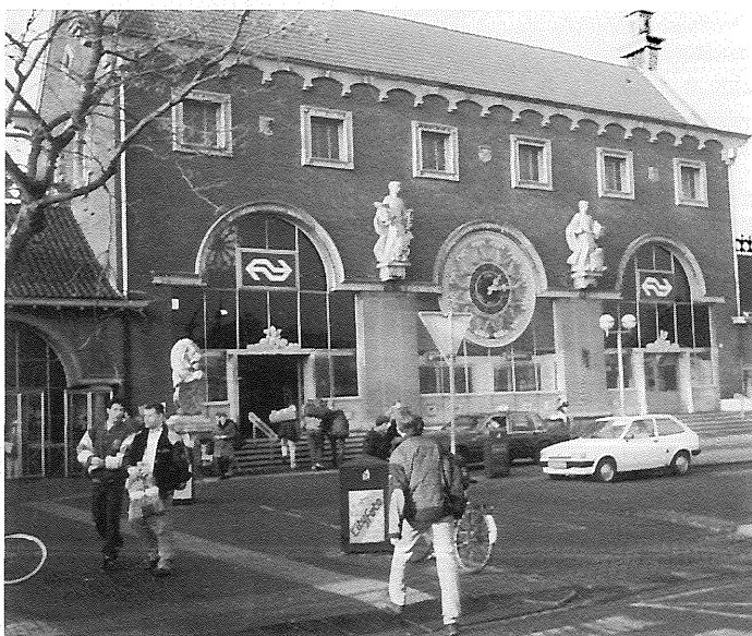
Het station in Den Bosch wordt gesloopt.
