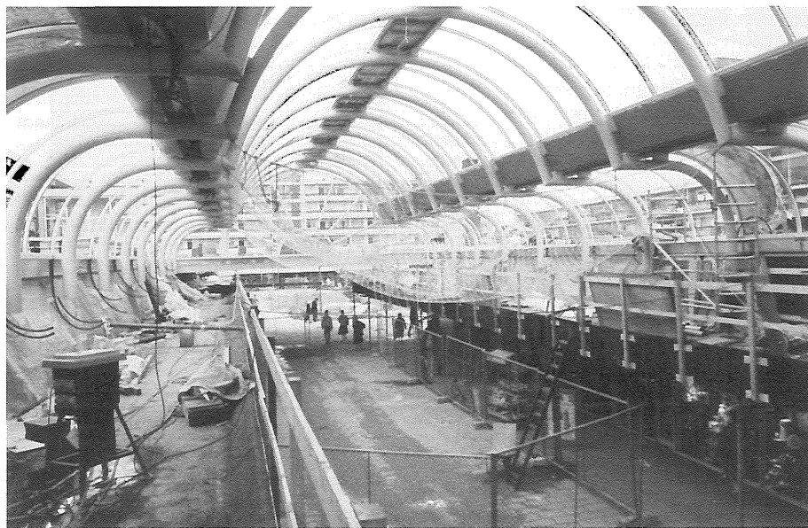
De renovatie van verouderde winkelcentra door middel van overkapping, is vaak succesvol zoals in het geval Presikhaaf in Arnhem. Foto: Fotoburo Peter Drent
