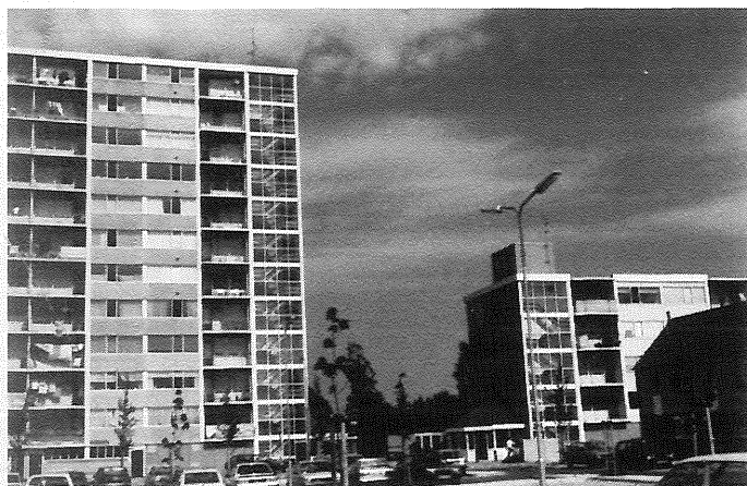
De Middelburgse hoogbouwwijk na de metamorfose: Links een gesaneerde flat met de oorspronkelijke elf verdiepingen, rechts de afgetopte flat. Op de onderste foto zijn de verruimde entree en de nieuwe eengezinswoningen te zien. Foto's: Hans Dronkers
