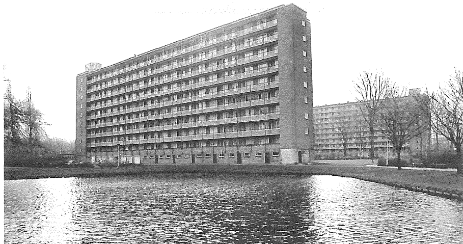
Naoorlogse woningbouw nu al aan beheer toe. Foto: Martijn Gallenkamp.
