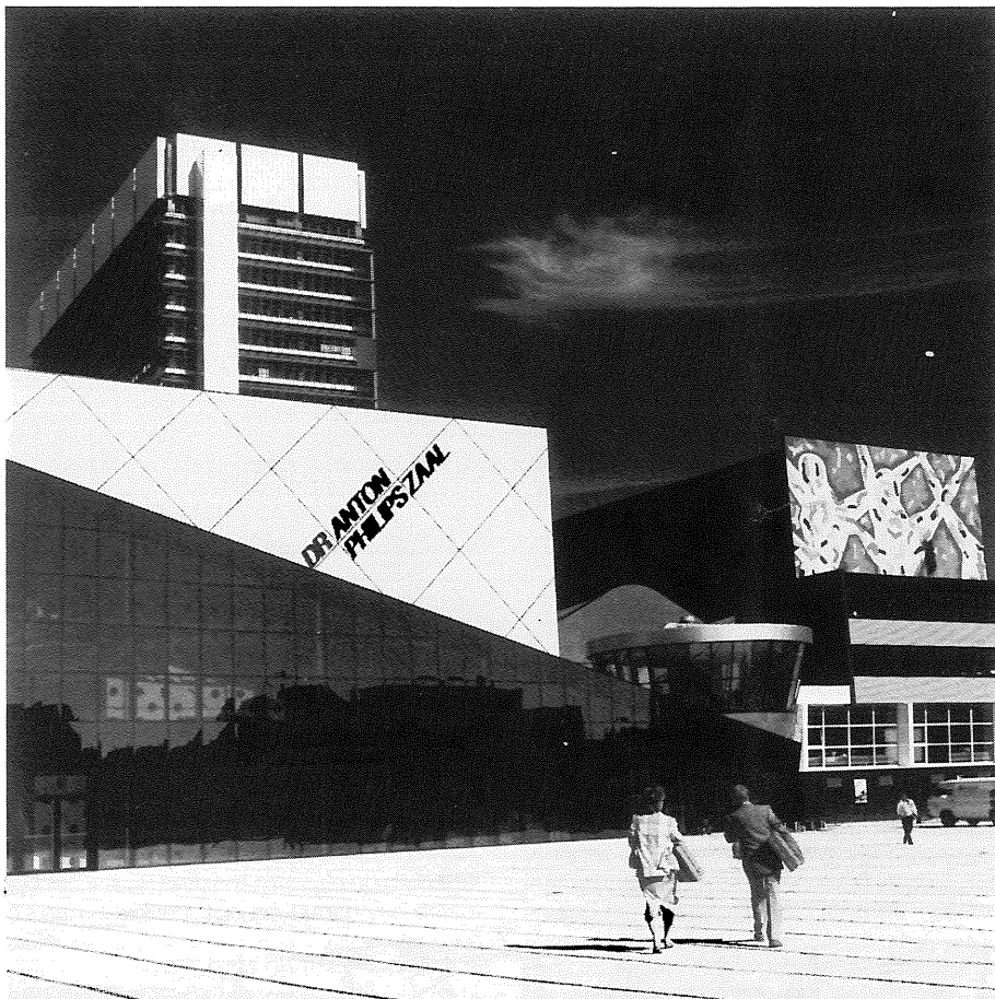
Een fraai 'dubbelgebouw'. Links de concertzaal van het Residentie-orkest, rechts het Danstheater. Foto: Mijs + Van der Wal, Bureau voor vormgeving en informatie-overdracht
