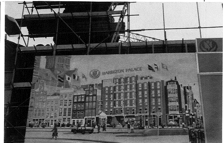
Als onderdeel van de revitalisering wordt 'op de kop van de Zeedijk' een hotel gebouwd. Het is de vraag of zo'n op zichzelf staande voorziening veel voor de buurt kan betekenen. Foto: Charlotte van Tirum
