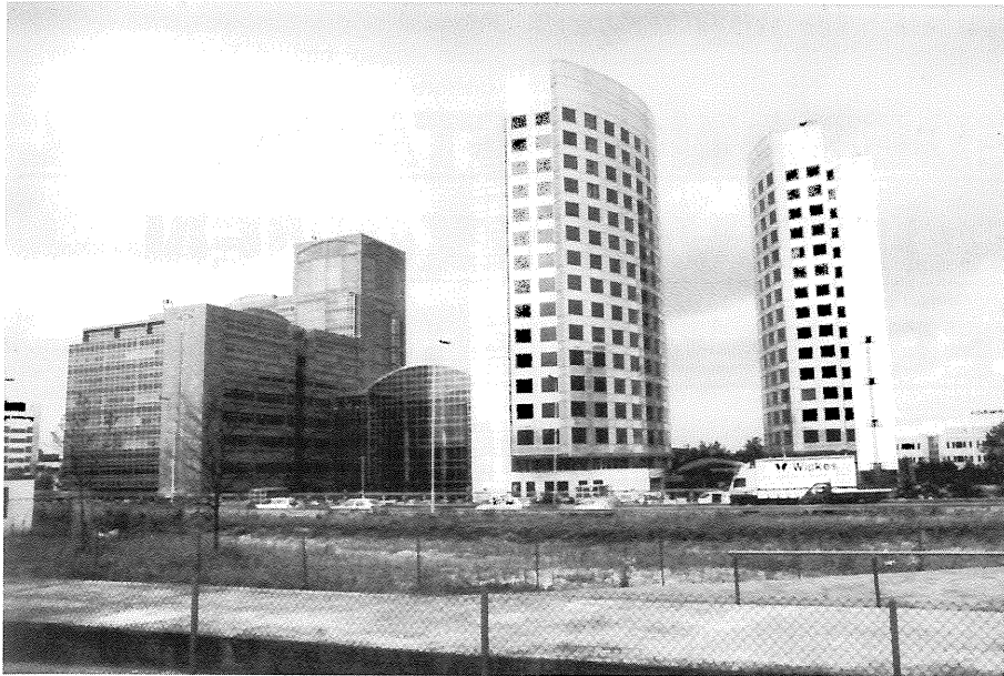
"Provinciale architectuur?", Oskam vindt van wel. Bron: MBO
