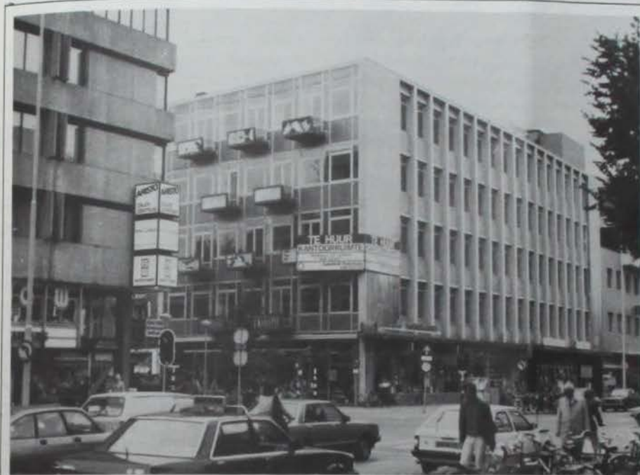
Dit kantoorpand aan de Vestdijk in Eindhoven wordt momenteel onderzocht op de mogelijkheden het als woonruimte in gebruik te nemen.
