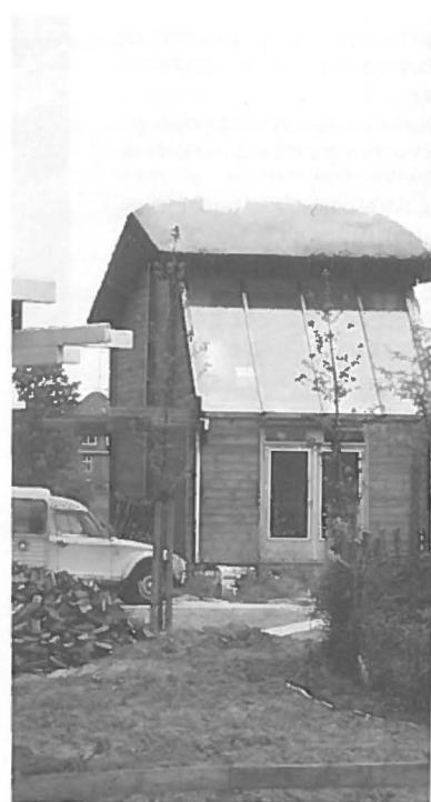
Woning met een groot glasoppervlak optimale benutting van zonnewarmte Bron: Ministerie van VROM.
