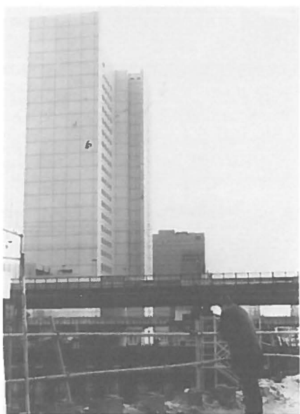
Een adembenemende bouwput. Foto: Annemarie van Bolhuis
