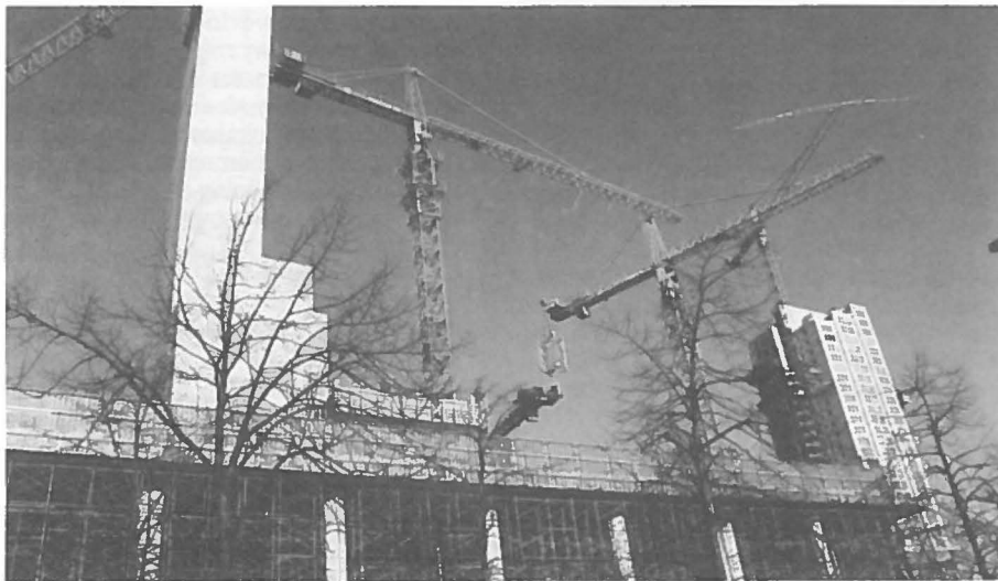
Bouwactiviteiten aan het Weena, met links het kantoor van Nationale Nederlanden en rechts een woontoren van het Sociaal Fonds Metaalnijverheid. Foto: Max Popma
