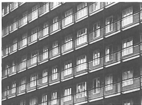
Galerijflats. Foto: Martijn Gallenkamp
