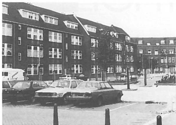
Van Alphenstraat/Bellamyplein. Bron: Projectbureau Spangen
