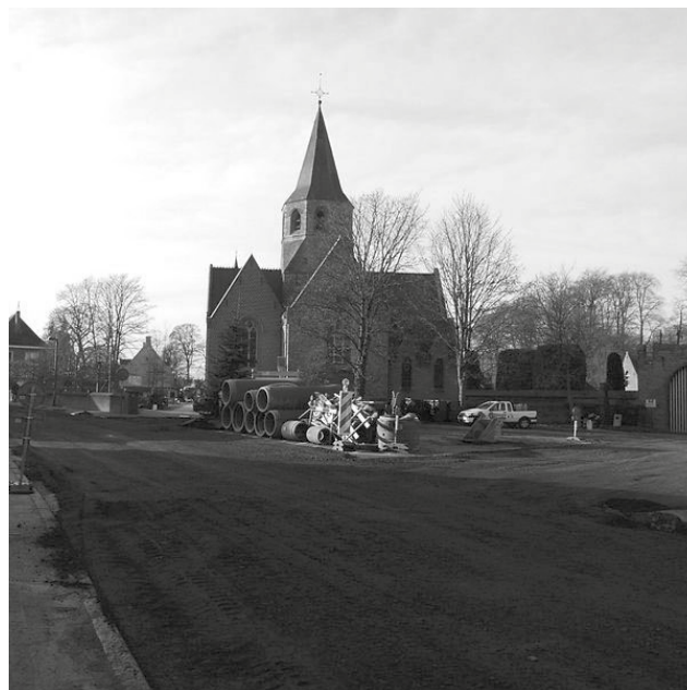
Klassieke heraanleg riolering en plein Schelderode.
